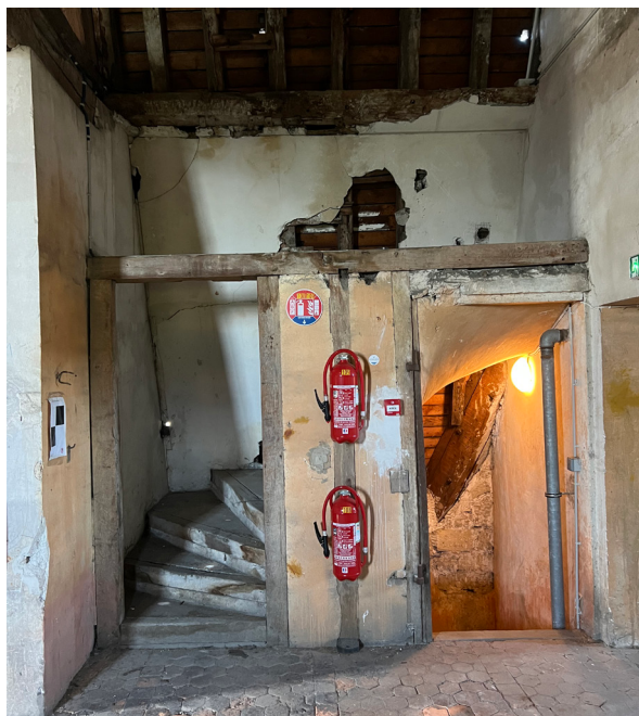
II. 21. Escalier aménagé pour accéder aux deux niveaux supérieurs des combles, aujourd'hui inexistantes, et aux niveaux inférieurs des entresols.
