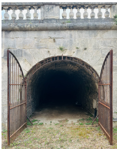
II. 25. Le tunnel voûté entre le village et le château.
