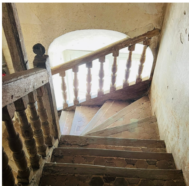
II. 5. Aménagement d'un escalier de service qui coupe l'agencement d'une grande fenêtre vers l'extérieur.
